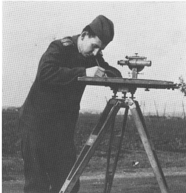
Topograf VTOPÚ, tehdejší kpt.Zdeněk Fiala u stolku topografa s eklimetrem Frič při celostátním IV. vojenském mapování českých zemí v měřítku 1:25 000
