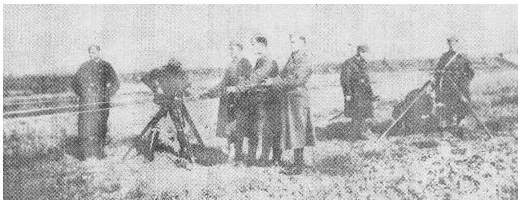
Měření základny u silnice z Mukačeva do Berehova
